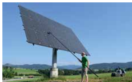
Reinigung mit Umkehrosmose: Für Photovoltaikanlagen, Fassaden und Glasfronten
