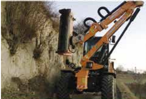
Arbeiten auf engstem Raum
