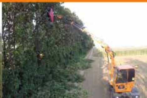
Freischneiden bis 13m Höhe
