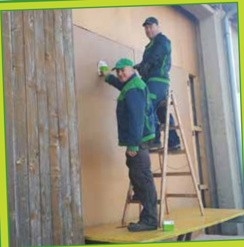
Unsere Allrounder bei Holzarbeiten an einer Trocknungsanlage für einen Landwirten.
