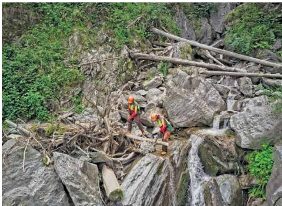
Die Beseitigung von Übelständen in Bachläufen ist ein Bestandteil des neuen „Naturgefahren-Service“ und verhindert Überschwemmungen – nicht nur im Hochgebirge.
