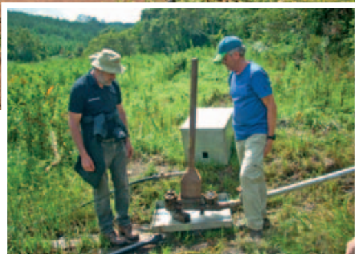
Armin Schwendinger und Franz Rauch bei der Inspektion der Wasserversorgung mit einem hydraulischen Widder.
