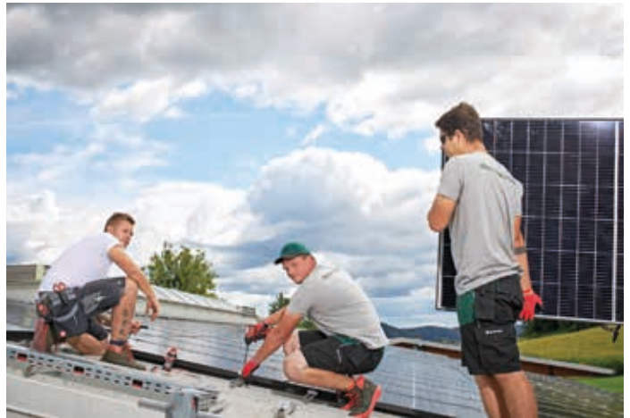
In luftiger Höhe: Mario, Philipp und Marco verlegen fleißig Module.
