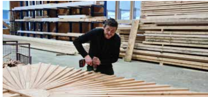
Die Dachstuhlteile werden in der Zimmerei millimetergenau vorgefertigt
