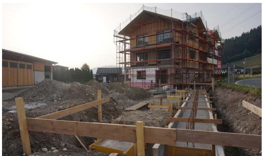
Im Bau wurde die Maschinenring-Philosophie umgesetzt, indem mit natürlichen Materialien und einem durchgängigen Energiekonzept gearbeitet wurde
