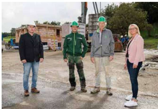
Teambesprechung auf der Baustelle: Georg Riß und Brigitte Ibertsberger mit Bernhard Wappis (li. Mitte) und Gerhard Stolz (re. Mitte)
