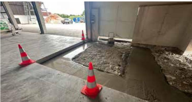
In die bestehende Halle kommt ein abgetrenntes Diesel- und Aspenlager. Hierfür wurde der Beton weggestemmt, ein Fundament für die Wände gegraben und der Durchbruch für das Tor und die Türe vorbereitet.
