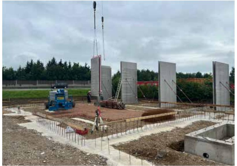
Ende Juni wurde das Fundament für die neue Halle gegraben und betoniert - kurz darauf wurden auch schon die ersten Fertigwände aufgestellt.
